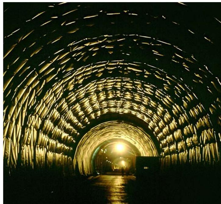
Eclairage provisoire de chantier dans un tunnel
